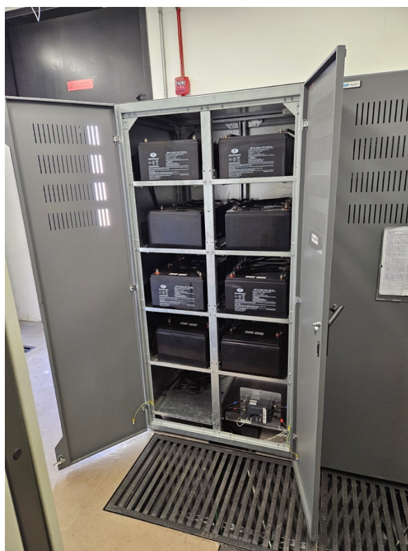
Figura 5 - Visão do banco de baterias aberto
