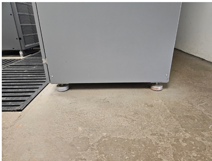
Figura 13 – Pés niveladores para o banco de baterias
