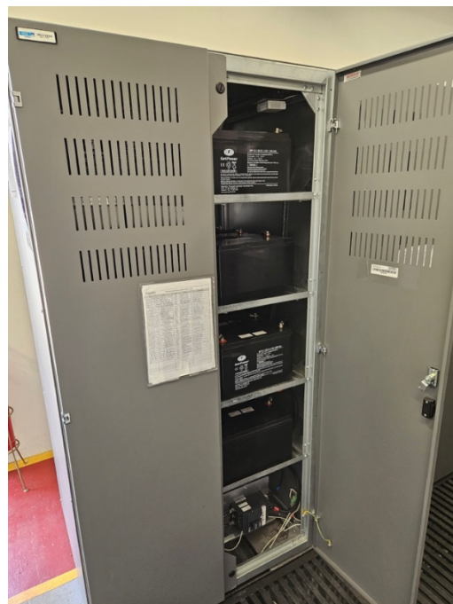
Figura 4 - Visão do banco de baterias
