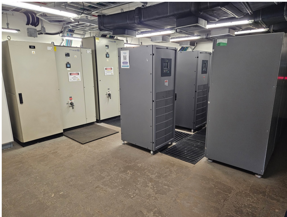
Figura 21 – Sala X do Prodasen, com 4 nobreaks instalados
